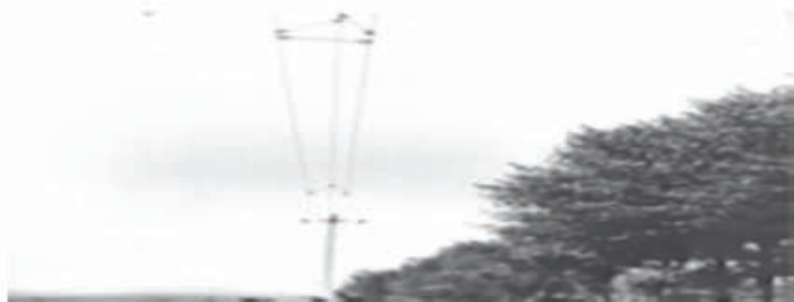
Рис. 1. Общий вид компактных линий электропередачи напряжением 10кВ.
