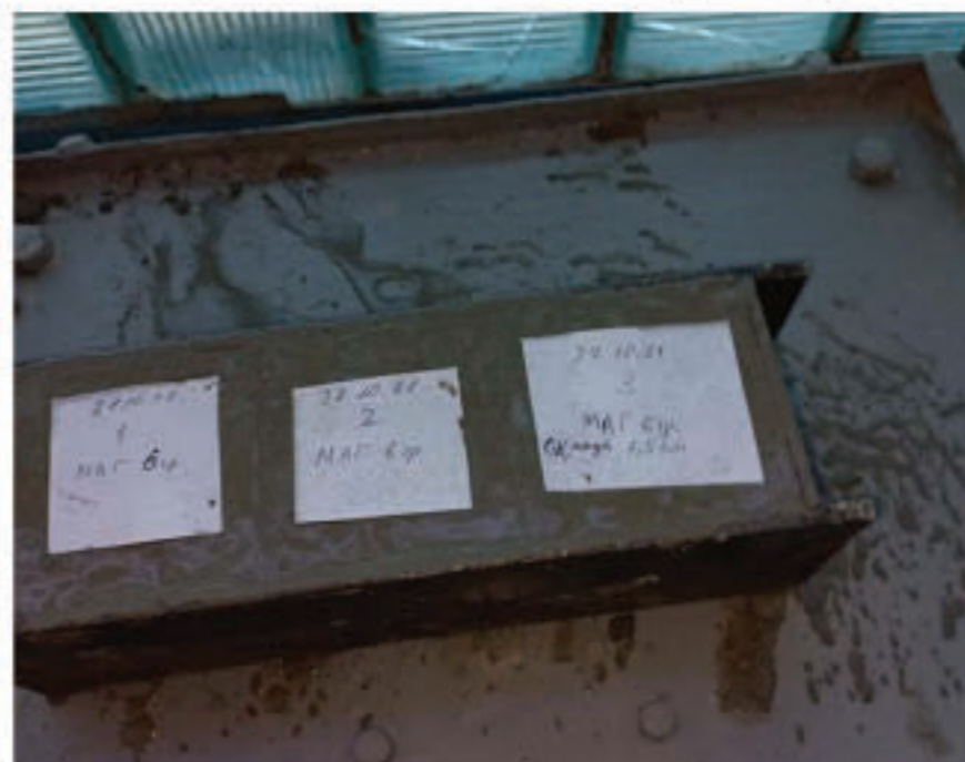
Рис.1а- бетонирование в металлической опалубке
